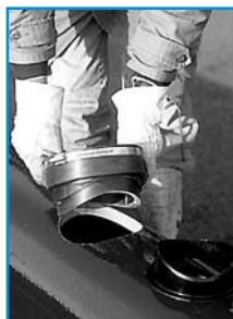
1. Вынимают сжимающую втулку и вводят соединительный элемент, соблюдая маркировку.
