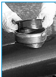
2. Подводят сжимающую втулку к направляющей.
